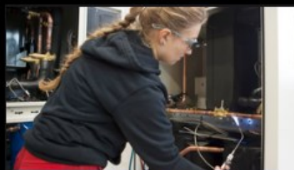
9:45 - 12:30 Uhr: Defektes Bauteil wechseln
