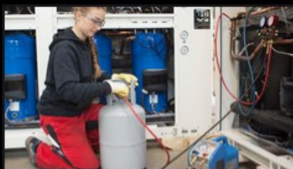
8:45 - 9:45 Uhr: Kältemittel abpumpen
