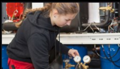
12:30 - 14:30 Uhr: Dichtheitsprüfung durchführen
