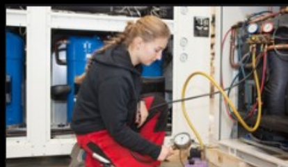
14:30 - 17:00 Uhr: Anlage evakuieren und in Betrieb nehmen
